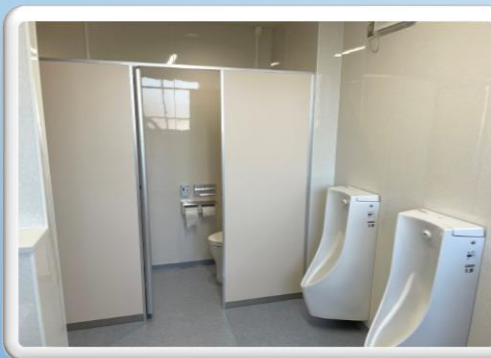
改修後の男子トイレ
